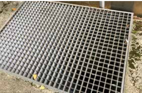
Lichtschächte sind für viele Kleintiere gefährliche Todesfallen. Engmaschige Abdeckungen helfen, diese zu entschärfen. Zudem verhindern sie Laubeintrag.
